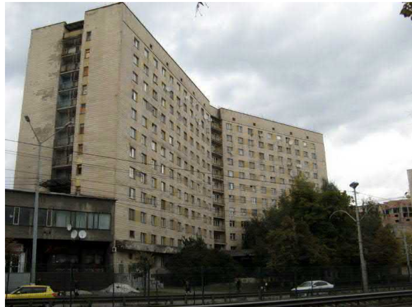
м.Київ, вул. Борщагівська, 146
